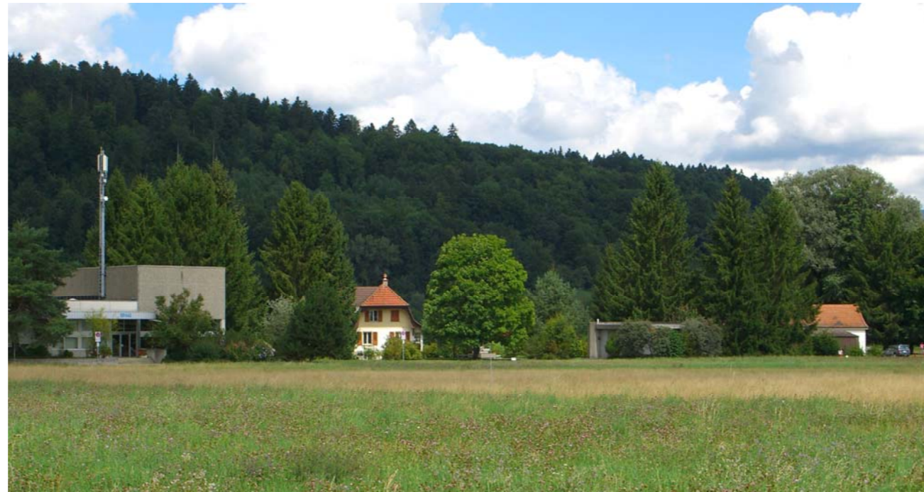
Blick auf die ökologisch bewirtschaftete Grundwasserschutzzone mit Hauptpumpwerk, Wasserturm, Grundwasserfassung und Weirstalt (von links nach rechts)
